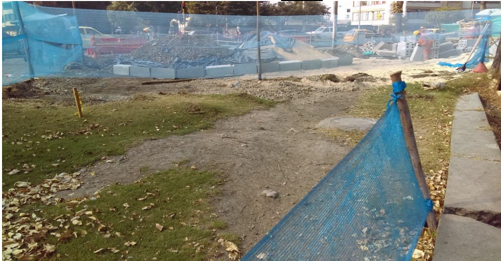
Fotografía No 1. Zona de intervención del Canal Arzobispo a la altura de la Calle 45, donde se desarrollan actividades constructivas.
