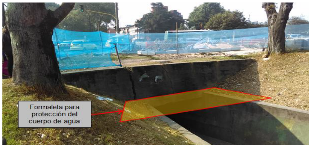
Fotografía No. 4. Zona de intervención sobre el canal Arzobispo, donde se ubicará una formaleta para la protección del cuerpo de agua y se reconstruirá un muro de contención. Se observan dos individuos arbóreos en la zona de influencia del proyecto.
